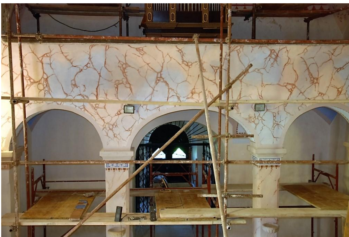
slika 2: pogled na pjevalište, stanje nakon radova
