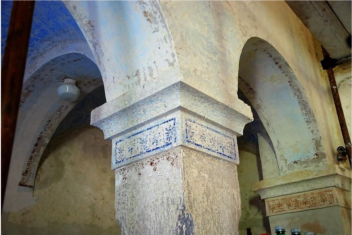
slika 3: pogled na pjevalište, detalj, stanje tijekom radova
