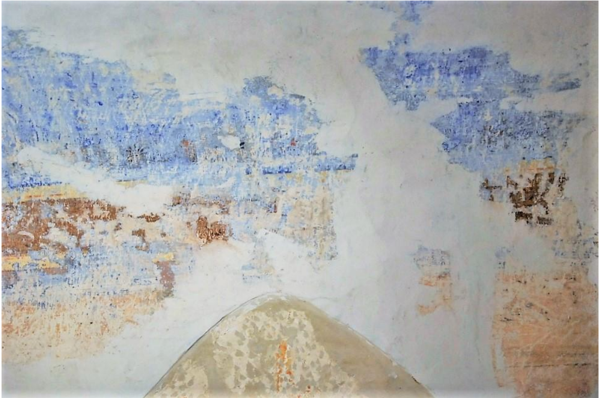
slika 19: detalj zidnih oslika, stanje tijekom radova
