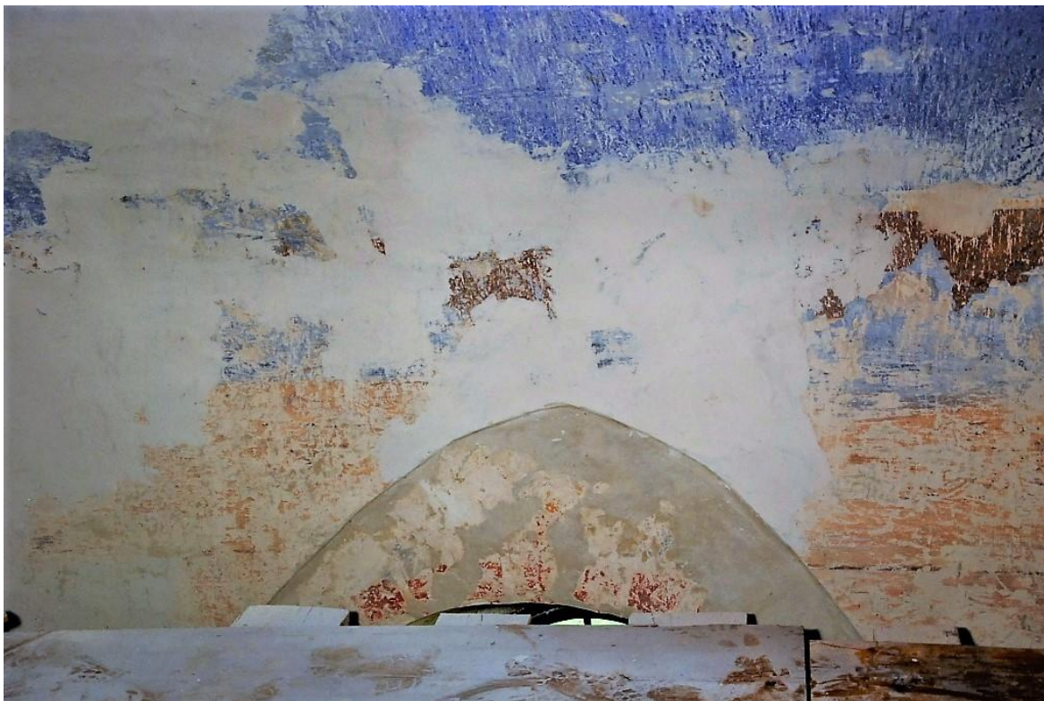
slika 21: detalj zidnih oslika, stanje tijekom radova
