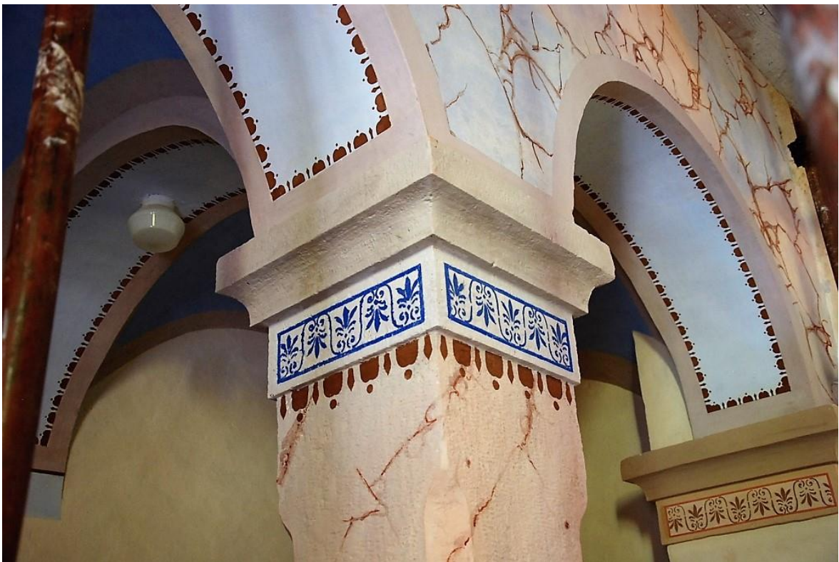
slika 4: pogled na pjevalište, detalj, stanje nakon radova
