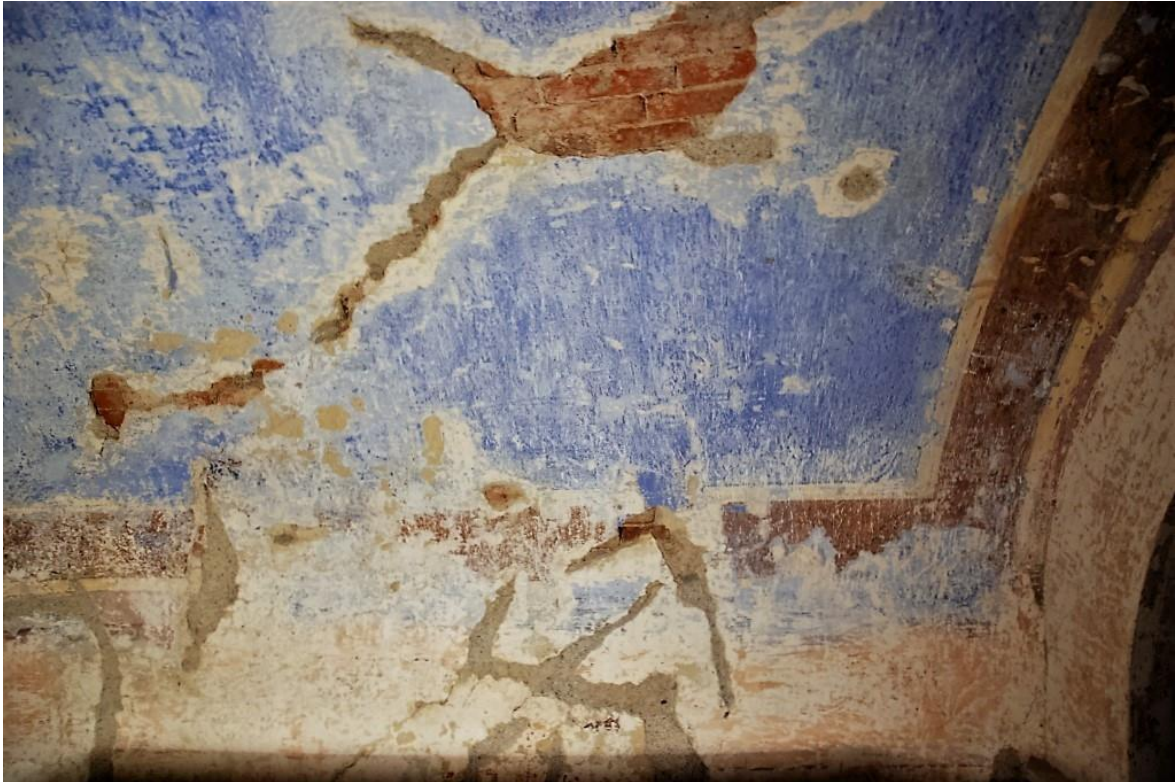
slika 7: detalj svetišta, stanje nakon otkrivanja oslika
