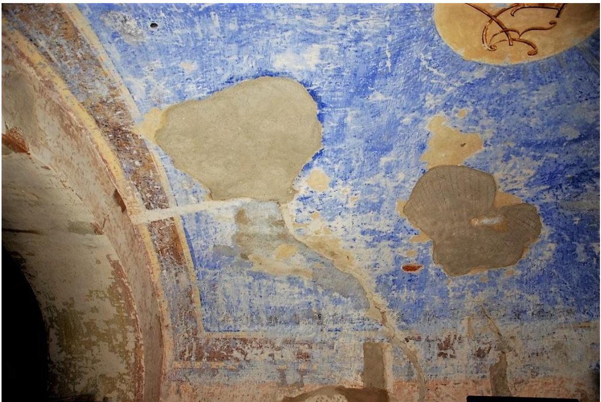
slika 10: detalj svetišta, stanje nakon radova
