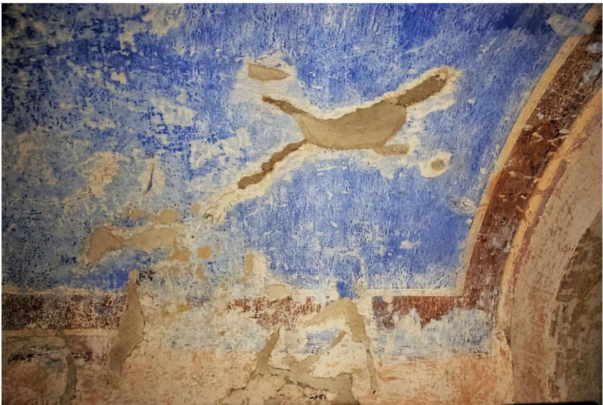
slika 8: detalj svetišta, stanje nakon radova
