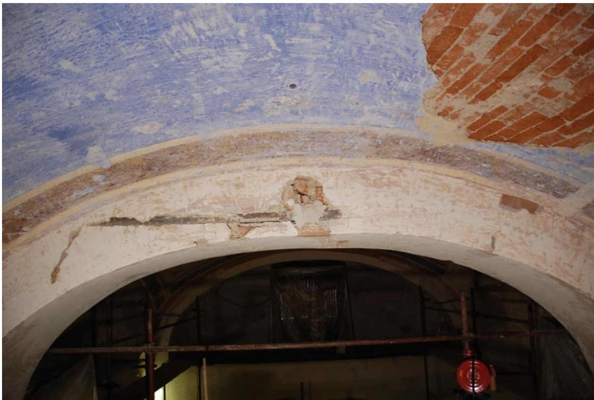
slika 5: detalj svetišta, stanje nakon otkrivanja oslika
