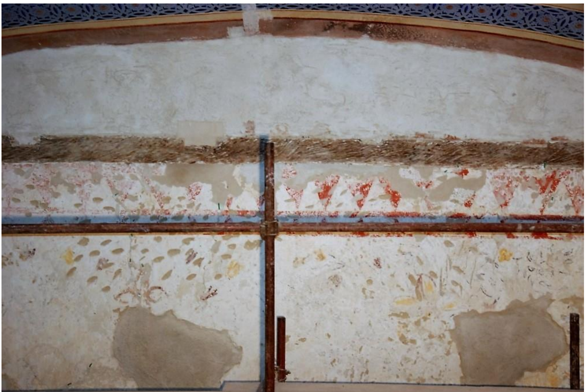
slika 17: sjeverni zid u brodu, detalj, stanje nakon radova
