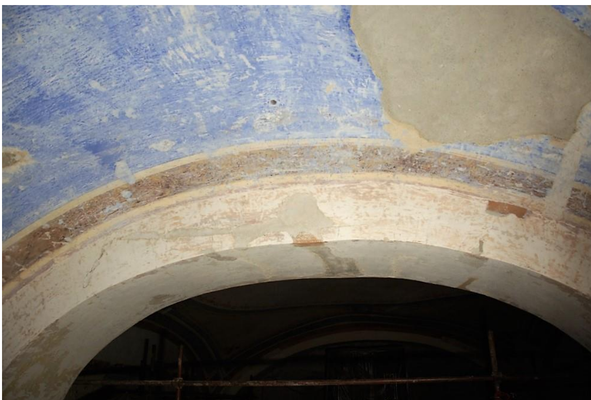
slika 6: detalj svetišta, stanje nakon radova
