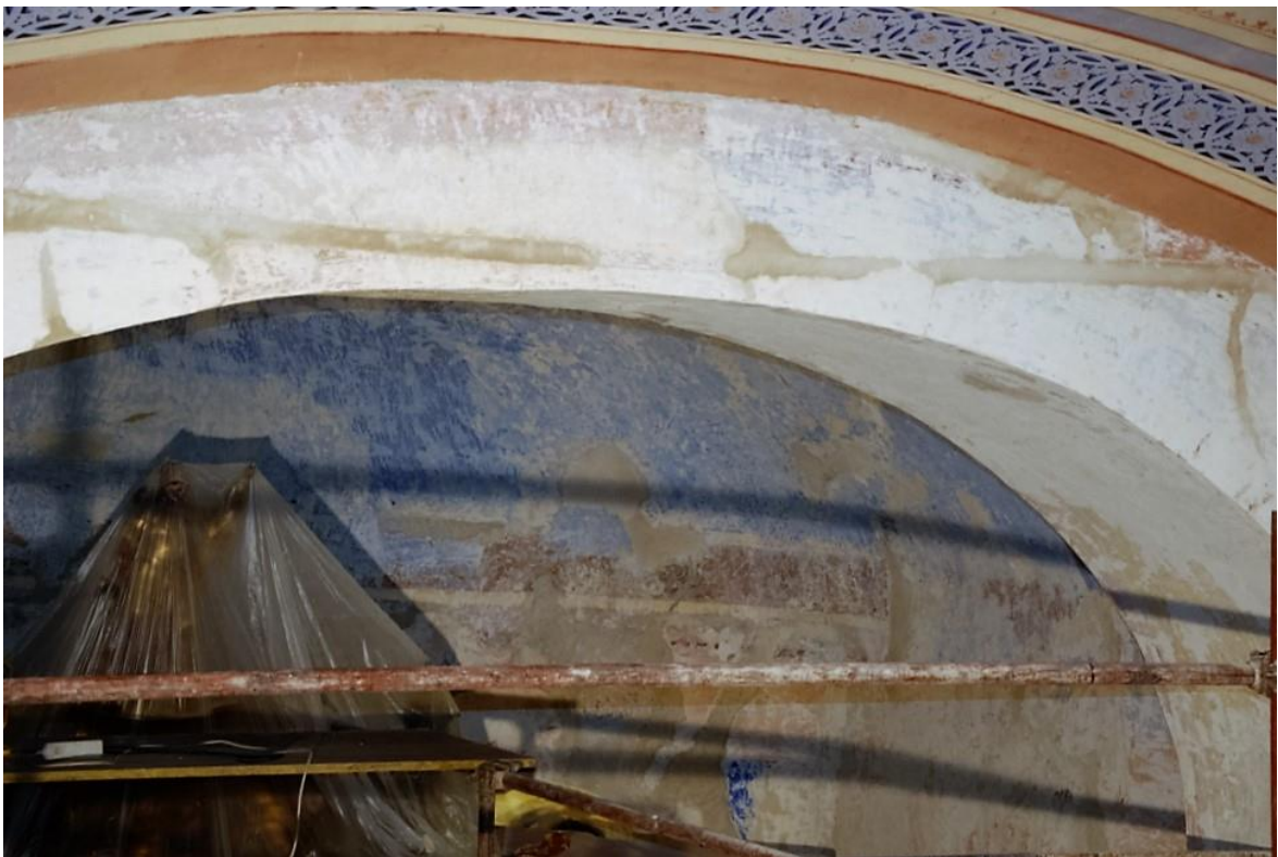
slika 4: detalj svetišta, stanje nakon radova
