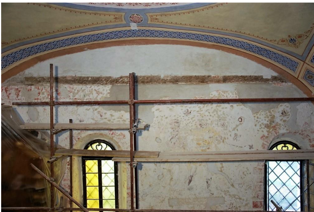
slika 13: južni zid u brodu, stanje nakon radova
