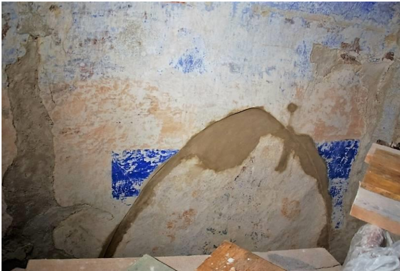
slika 19: ostaci starijeg svoda u svetištu
