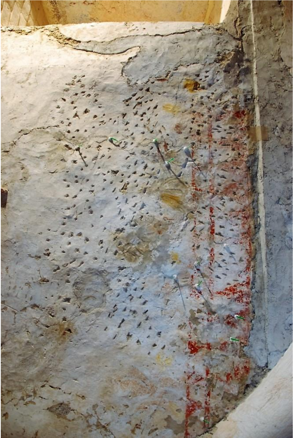
slika 11: injektiranje nositelja slikanog sloja
