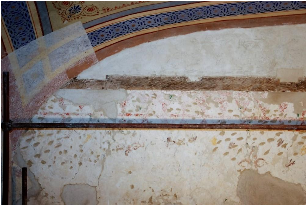
slika 16: sjeverni zid u brodu, detalj, stanje nakon radova
