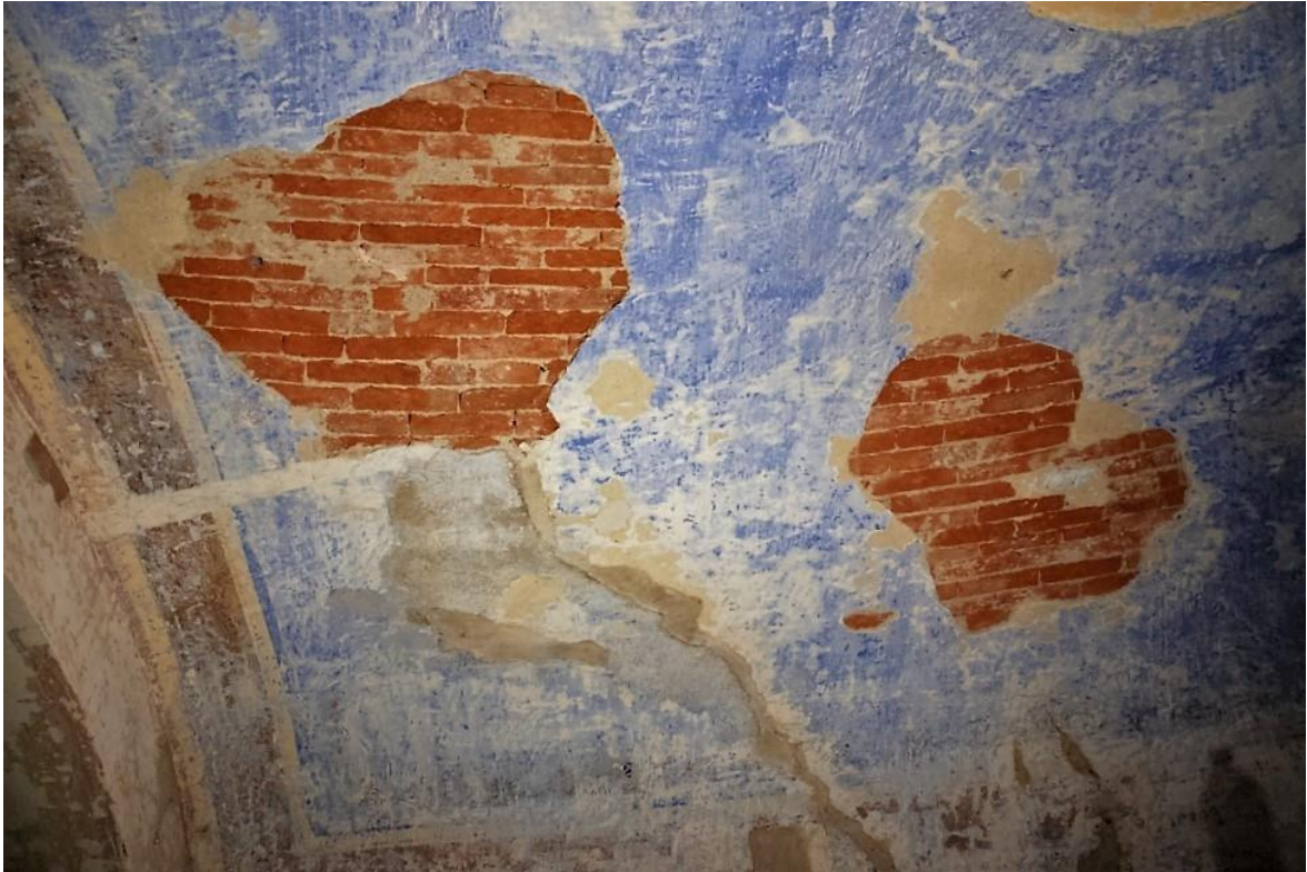
slika 9: detalj svetišta, stanje nakon otkrivanja oslika
